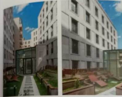
Рис. 3.4. Эксплуатируемая кровля жилого комплекса Veten Place, Санкт-Петербург, Россия [31]. Архитекторы С. Чобан, А. Болдырев. Фото Д. Чебаненко
